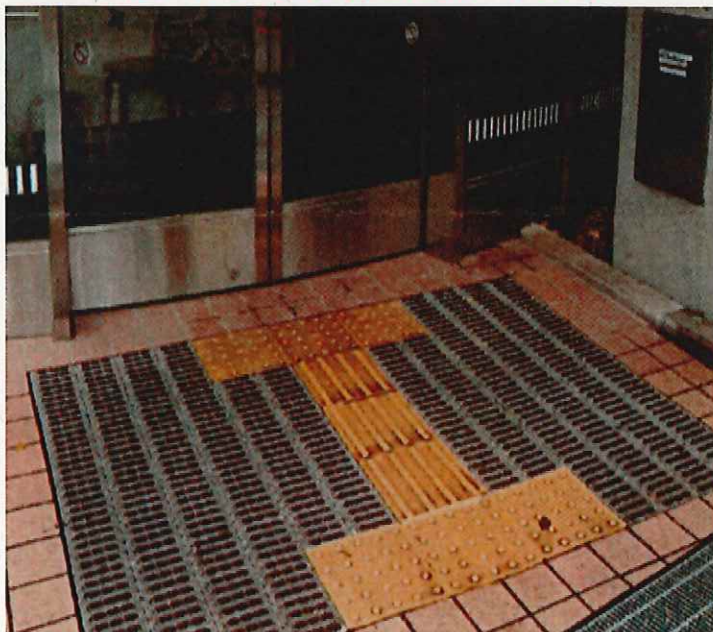
出入口の凍結、積雪防止 (ブラシ状の固定タイル)
