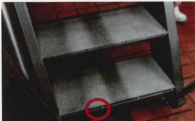
スリップ防止施工
