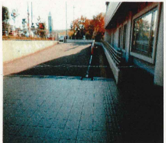
点字ブロックに 塩化カルシウム散布
