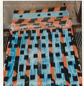
排水溝をスロープ化
