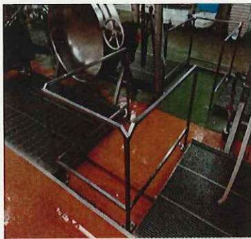
段差に柵設置
